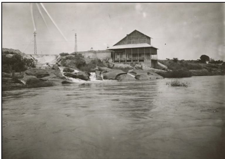
Photo n°3. L'usine et la chambre de mise en charge. A gauche le canal d'amenée déverse son trop plein.
