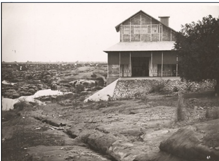
Photo n°4. Le bâtiment de la centrale.
