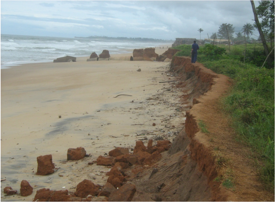
Photo 1: Interruption de la voie Balmer - Village Fanty en aval dérive de la station d'extraction de sable (septembre 2010)
